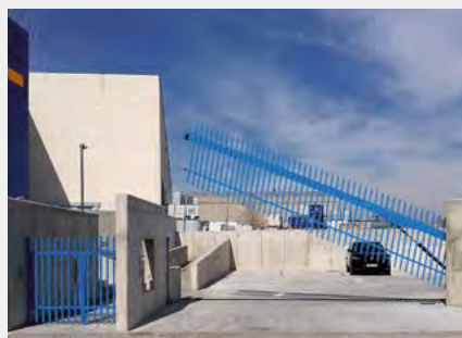
Conjunto de puerta vertical y peatonal en industria química.
