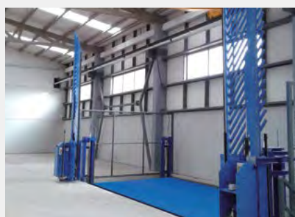
Puerta combinada con un montacargas.
