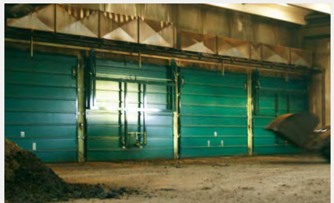
Después de la instalación.
