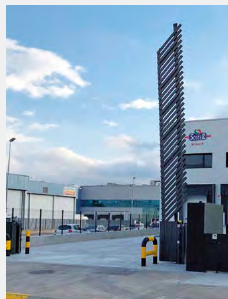
Vista abierta de la puerta en acceso a industria.
