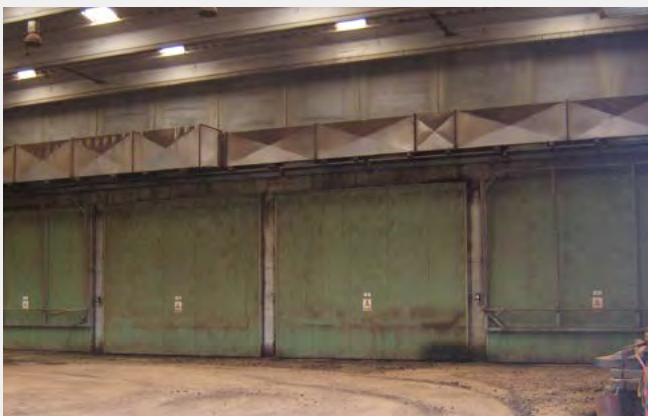
Antes de la instalación.
