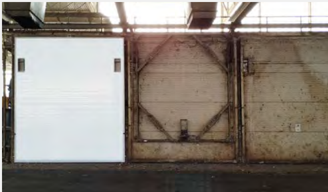
Remplazo de las puertas en una planta de compostaje.
